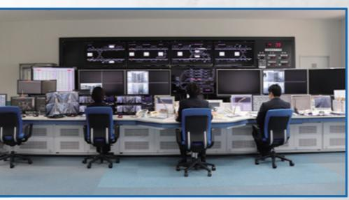
リニモの運行状況を管理する運転指令室。ホームの様子がディスプレイに映し出され、混雑状況によってはドアの開閉時間や遠隔操作で調整したりもする。天候や風速など気象情報の表示もある。
