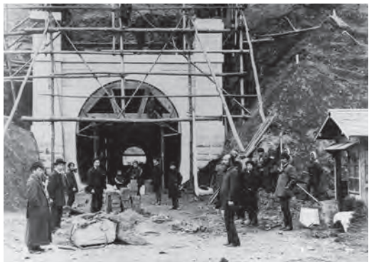
明治21年、第二トンネル東口の洞門工事。疏水で大量に使われた煉瓦は、京都府山科区御陵原西町にあった琵琶湖疏水煉瓦工場で生産された
