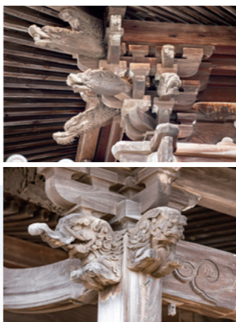
本堂の組物が見事だ。上層の屋根の下には龍の彫刻の木鼻が取り付けられており、向拝の虹梁にある木鼻は漢と獅子の彫刻である
