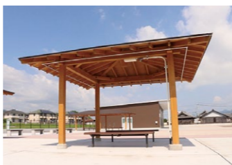
東屋 災害時の支援活動の際には横幕を張り、応急救護所などとして活用可能です。屋根内側には非常用電源を完備
