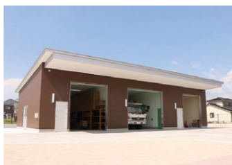
防災用備蓄倉庫 TENT や食料、投光器、排水ポンプ車、LP ガス非常用発電機などの防災資機材が保管されています
