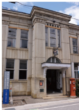
大正4(1915)年に建てられ、昭和48(1973)年まで「醒井郵便局」として使われていた擬洋風建築物。昭和9(1934)年に外壁をモルタル張りに改築するなどの改修が行われた。国登録有形文化財
