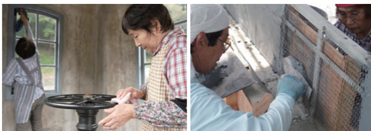
右)「制水井上屋」の壁は、現代にはない「鉄骨鉄網モルタル造」の工法のままに修復。窓枠のベンキも忠実に再現した。左)4~11月の間、保存会の会員が常駐し、草刈りや河川清掃などの清掃美化作業、ガイドなどを行う
