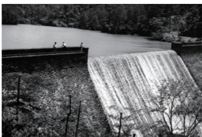
水害で決壊した土製のダムを粗石張・重力式コンクリート造で再建設。かつては上部の広い切り込みから水が流れ落ち、「美歎の大瀑布」と呼ばれた
