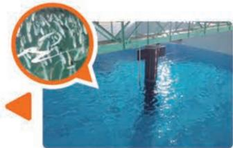
育成棟には直径14メートル、深さ5.4メートルの4つの水槽を設置。給餌や魚の移送もすべて機械が担当
