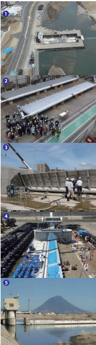
写真1~4:新しい潮止堰の建造過程。銅製のゲートを起こしたり倒したりして、堰の高さを調節する仕組み 写真5:昭和54年に作られた旧潮止堰。堰の部分は、巨大なゴム製。内部に空気を送り、膨らませたり、萎ませたりして堰の高さを調節
