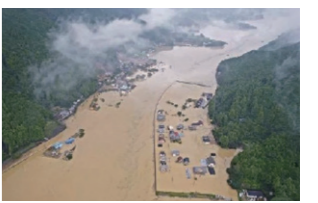
堤防の決壊により浸水被害に遭った紀伊半島大水害～平成23年台風12号による災害の記録～より
