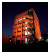
中広本社ビル
