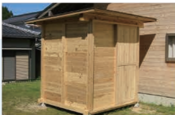
根羽スギを使ったセルフビルド物置「根羽物置」。スギ板を柱の間に落とし込む外壁構造のため、素人でも半日くらいで簡単に組み立てができる
