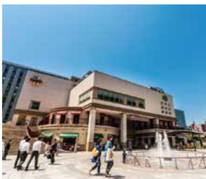
13店の多彩なレストランが入るプラザ棟
