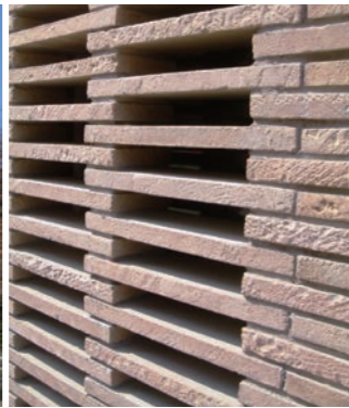
愛・地球博の瀬戸愛知県館を活用した地上3階、地下1階のあいち海上の森センター。外装に使用しているタイルはワッツビジョンの制作です
