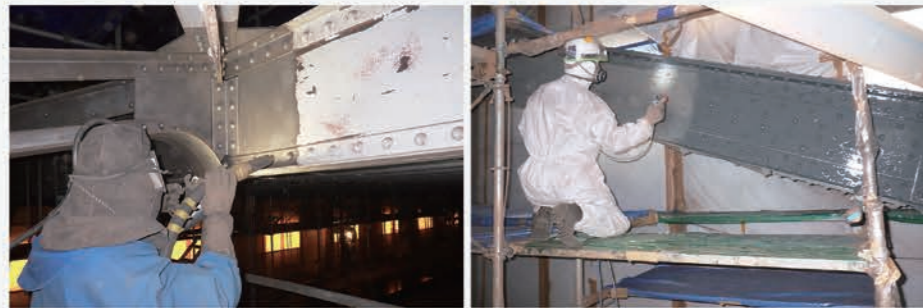
◎循環式エコクリーンプラスト工法を用いた作業の様子 ◎プラスト作業の後は、下地の塗装
