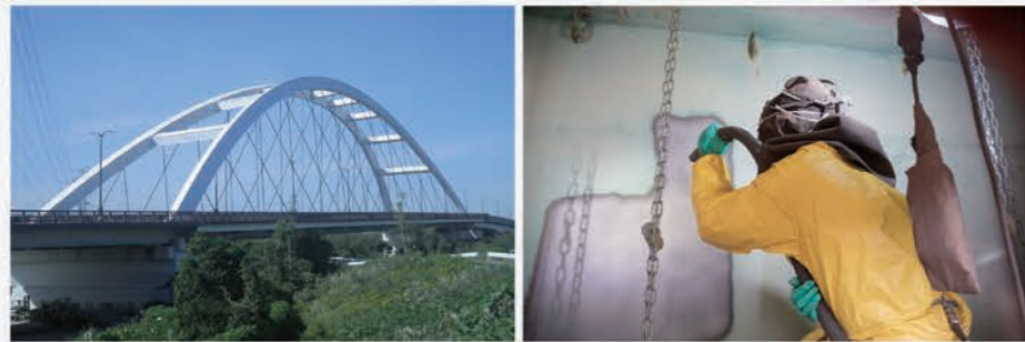
◎補修を手掛けた豊田市の平成記念大橋 ◎静岡県にある志都呂西大橋の塗装面を循環式エコクリーンプラスト工法で剥がしていく
