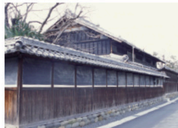
【北高塙】 屋敷の周囲を囲むように設けられた高壁。なかでも主屋北側の高塙は、玉石を積み格子窓が付いている
